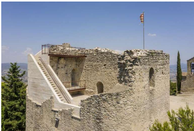
Şəkil 6. Santa Margarida de Montbui qəsrinin siqnasiya üsulu ilə franqmentar bərpa, İspaniya
